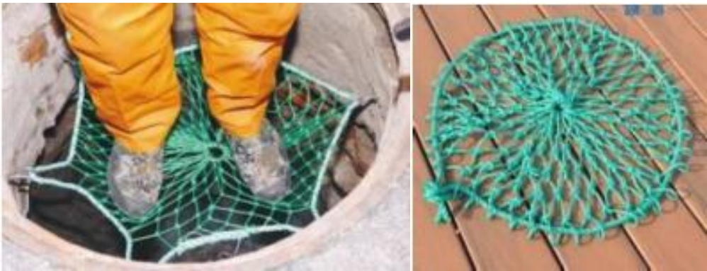
图 6-3 检查井防坠落装置
