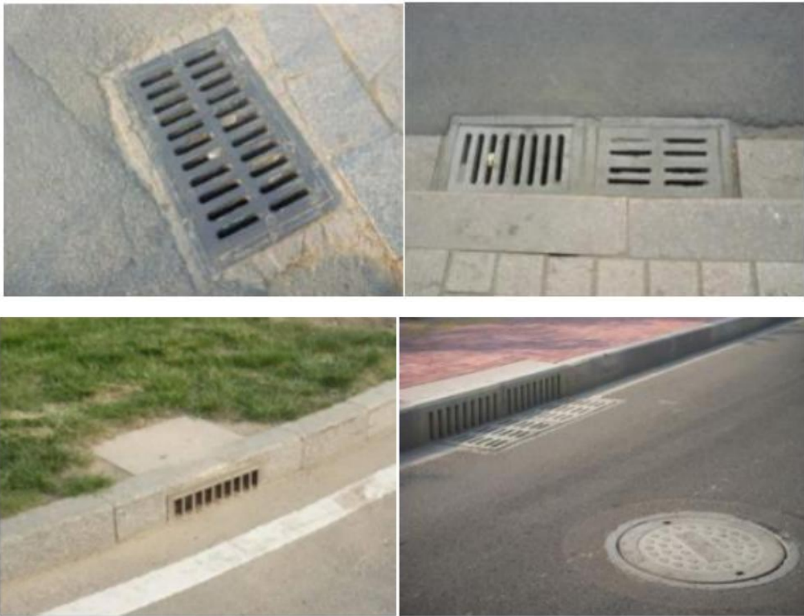
图 6-2 平算式单算、双算雨水口，立算式单算雨水口，合式雨水口
