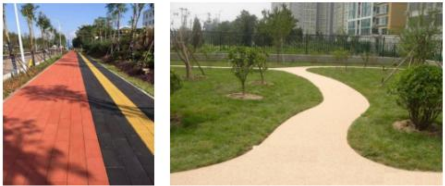
图 5.3-4 透水铺装实景图
