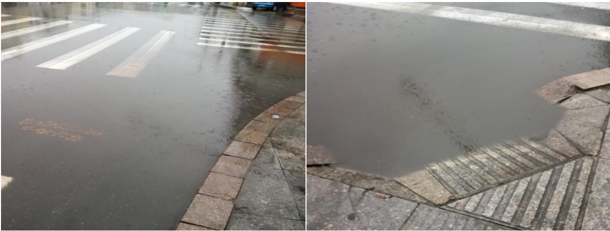
图 2-10 涌泉路与霞光路交叉口产生积水
