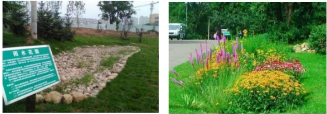
图 5.3-10 生物滞留设施实景图
